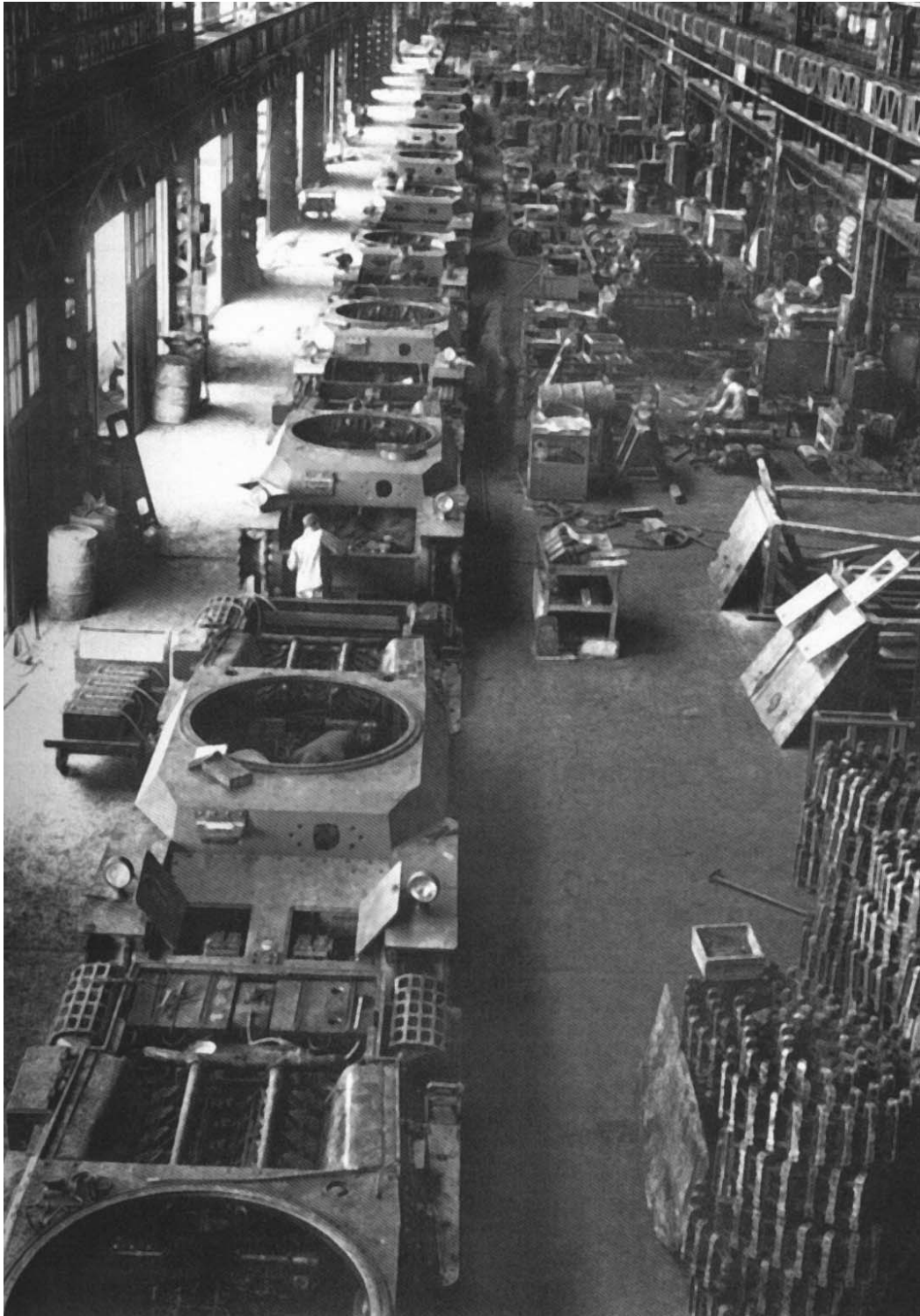
Сборка танков на японском заводе
